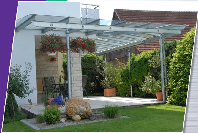
Terassenüberdachung aus Stahl feuerverzinkt mit Klarglaseindeckung
